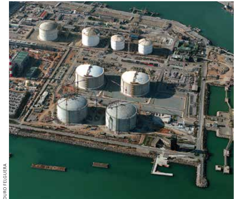
Central de ciclo combinado Puerto de Barcelona y tanques de almacenamiento para la regasificadora
