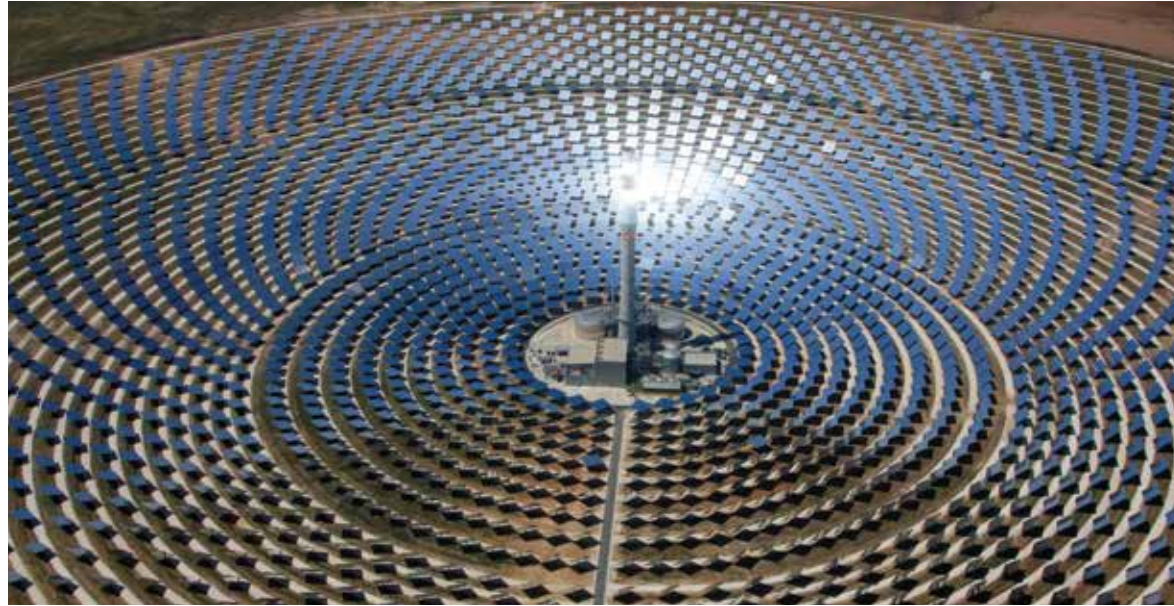
Planta solar Gemasolar, propiedad de Torresol Energy y desarrollada por SENER
